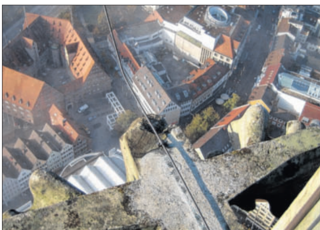
Diese Kabel (links) schützen das Münster vor Blitzen. An der Spitze weist der Blitzschutz in alle Himmelsrichtungen. Über Steigeisen muss Patrick Winter, der die Bilder aufgenommen hat, nach oben.
