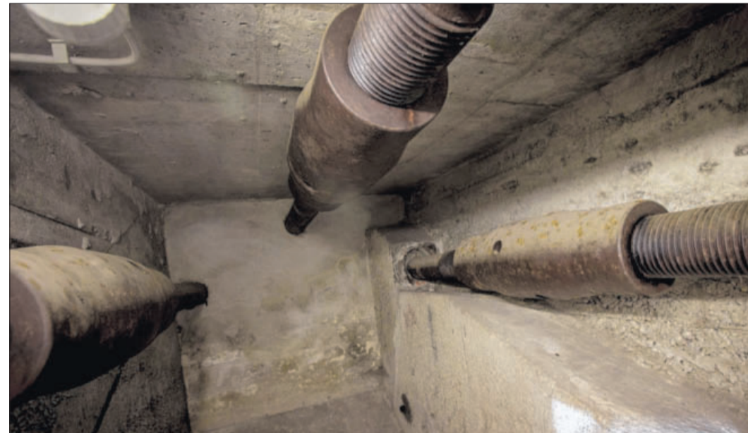
Das Münster sicher verankert: Anhand dieser Haken (Bild links) messen Steinmetze ob sich die Steine bewegen. Erwin Straub steht auf dem Granitfundament (Bild oben) und klopft an die Anker. Die wurden vor 90 Jahren eingebaut, das Fundament vor 130 Jahren. Dieser Anblick (Bild rechts) bietet sich, wenn man durch den engen Kellergang zum Turmfundament guckt. Fotos: Matthias Kessler
