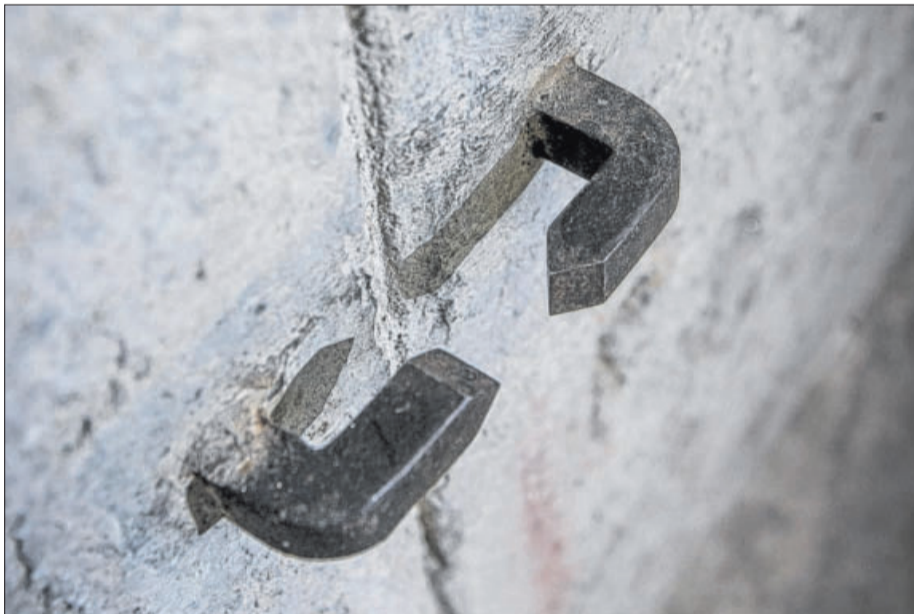
Das Münster sicher verankert: Anhand dieser Haken (Bild links) messen Steinmetze ob sich die Steine bewegen. Erwin Straub steht auf dem Granitfundament (Bild oben) und klopft an die Anker. Die wurden vor 90 Jahren eingebaut, das Fundament vor 130 Jahren. Dieser Anblick (Bild rechts) bietet sich, wenn man durch den engen Kellergang zum Turmfundament guckt. Fotos: Matthias Kessler
