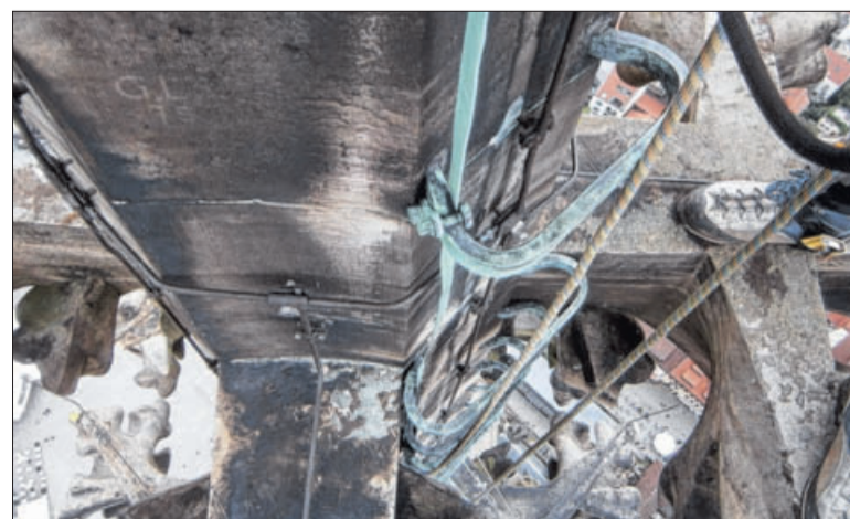
Diese Kabel (links) schützen das Münster vor Blitzen. An der Spitze weist der Blitzschutz in alle Himmelsrichtungen. Über Steigeisen muss Patrick Winter, der die Bilder aufgenommen hat, nach oben.
