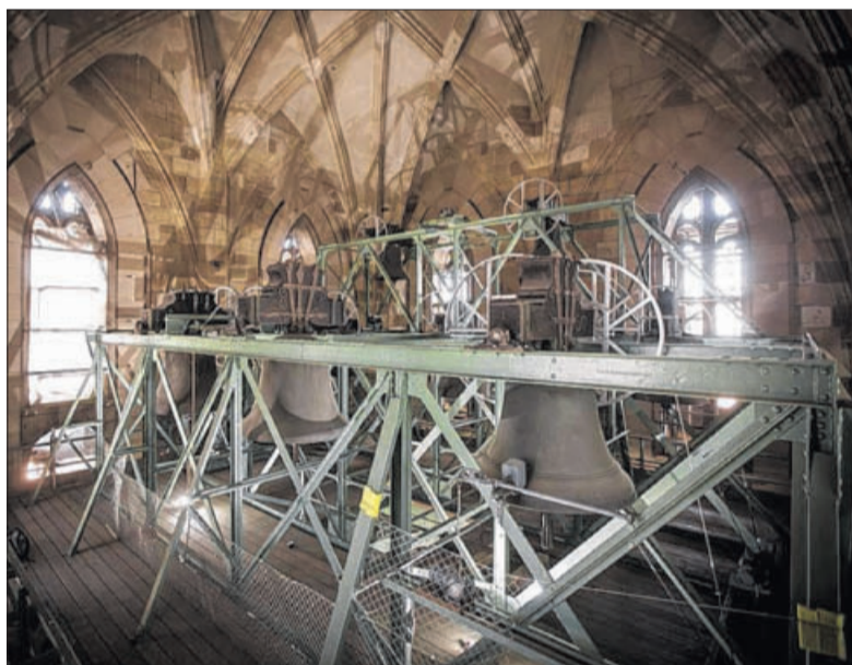
Der Glockenstuhl wurde von 2005 bis 2009 aufwendig saniert. Dafür mussten alle zehn Glocken abgenommen werden. Jetzt sind alle wieder an Ort und Stelle.
